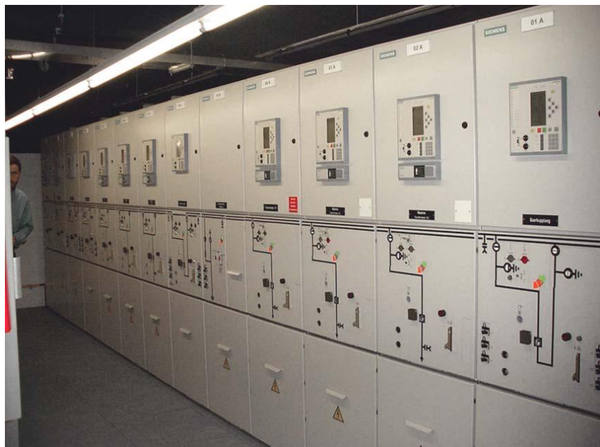
Abbildung 1: Hochspannungs-Schaltanlage.
