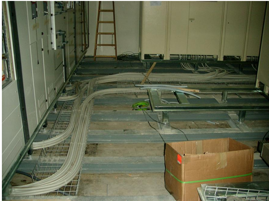
Abbildung 3: Etappenweise Inbetriebnahmen bergen besondere Gefahren: Baustelle Energiezentrale.
